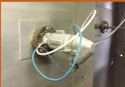
Le pyromètre infrarouge TX D54 permet de mesurer la température de gaz CO<sup>2</sup> de flammes, comprise entre 250 et 1650 °C.
